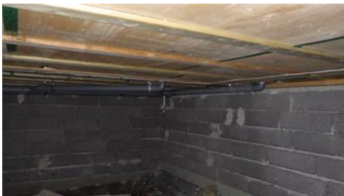
Översiktsbild krypgrund (tillbyggnad).
