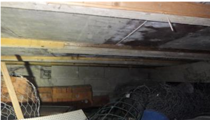
Översiktsbild krypgrund under lillstuga.
