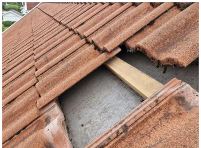
Tak, underlagstak av väv ursprunglig del.
