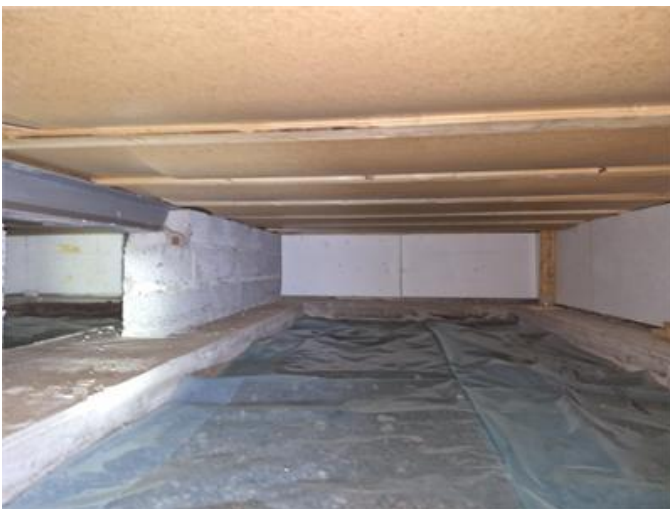
Krypgrund, översiktsbild utbyggnad vardagsrum.
