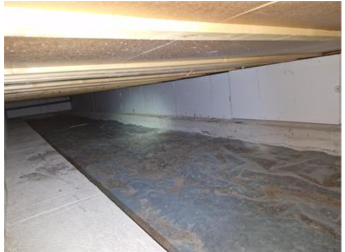
Krypgrund, översiktsbild södra delen.
