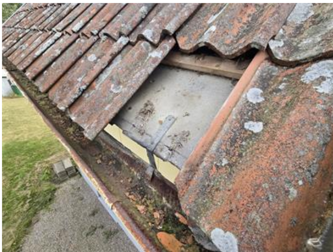
Tak: Stickprovskontroll under pannor, nedersta raden ligger direkt på papp.
