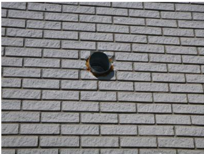
Imkanal dragen i fasad
