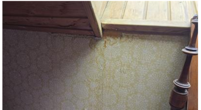
Exempelbild, rinnmärken/fuktfläckar kring takfönster, övre plan.
