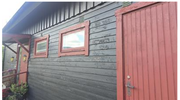
Exempelbild, målning/underhållsbehov fasad.
