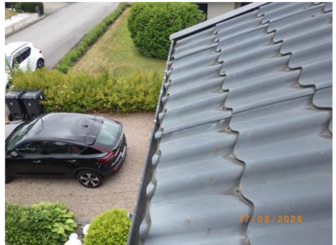
Takplåten avslutas delvis på ena sidan av takfallet för långt ut i hängränna.
