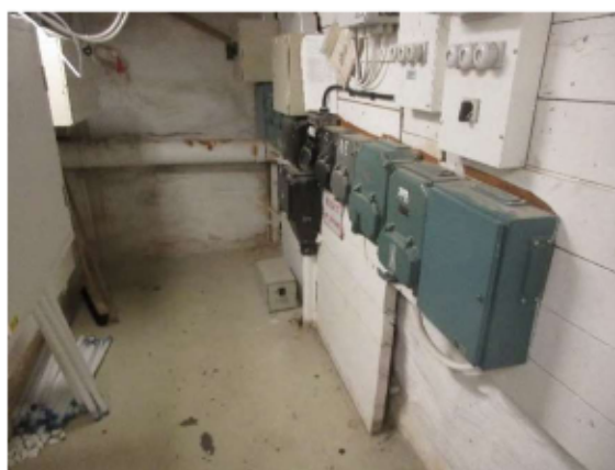
Delar av ej bytta elektriska installationer
