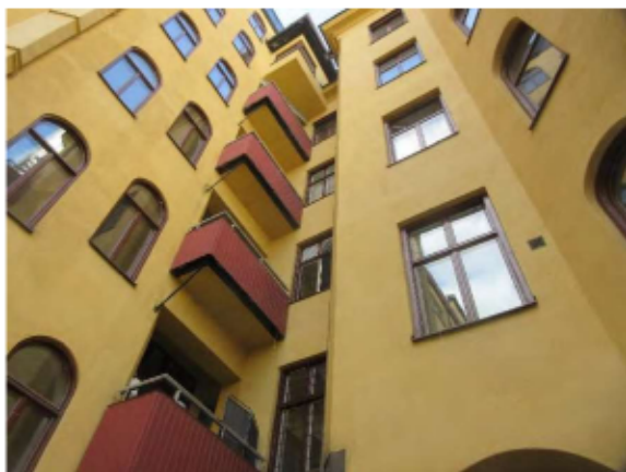
Gårdsfasad med balkonger i gott skick
