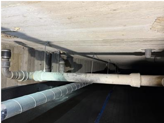
Bild från kryppgrund
