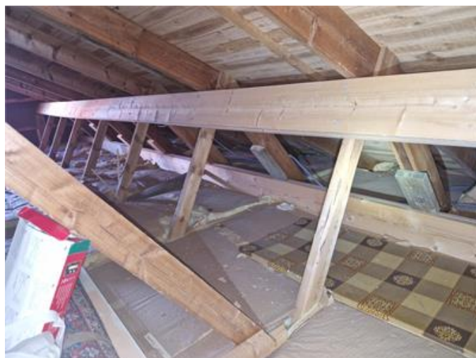
Nockvind, takstolar förstärkta ovan östra långsidan.
