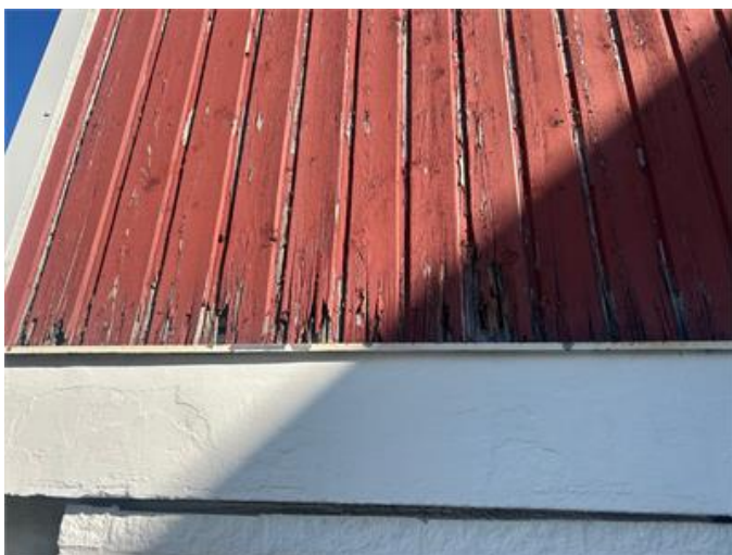
Rötskadad fasadpanel.
