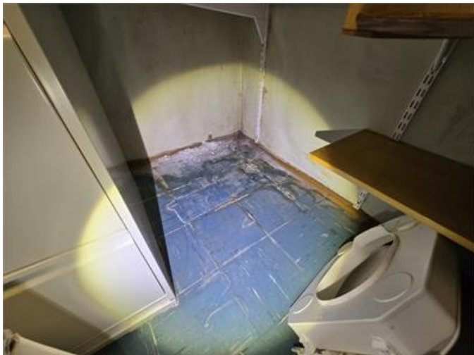
Källare: Exempelbild på fuktanvisning på golv samt grundmurar.
