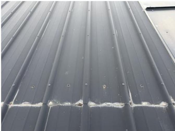
Skarv låglutande plåttak.
