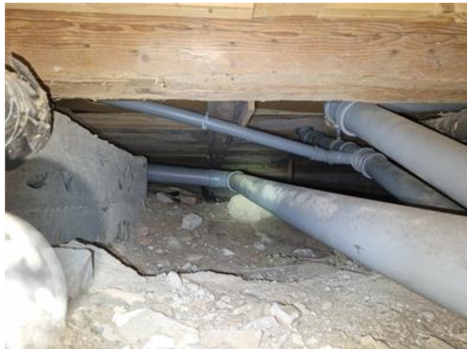
Krypgrund mellersta delen.
