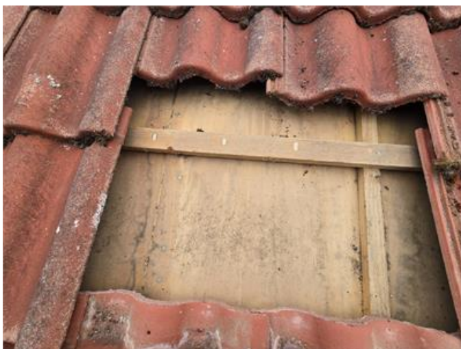
Tak: Stickprovskontroll under pannor på ursprungsdel, träfiberskivor utan yttre täcking av papp, fuktanvisningar noteras.
