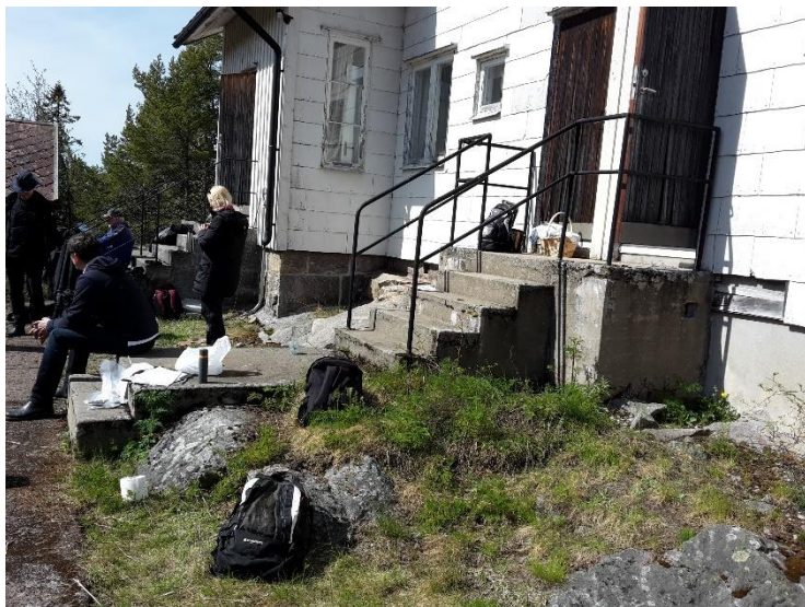
Bild 9: Betong trapp prov 10.
