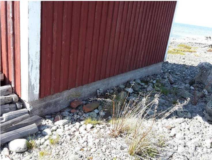
Bild 23: Betongsockel.
