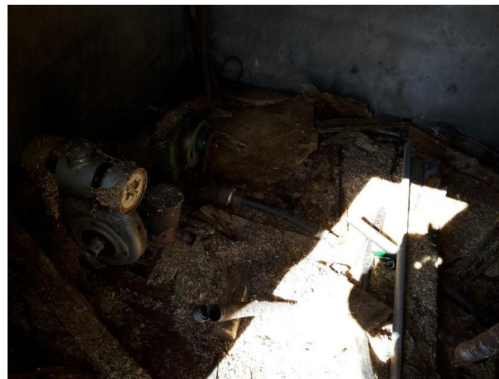
Bild 20: Pumphuset invändigt. Bensindriven kolvump. Inga tecken på spill eller läckage.
