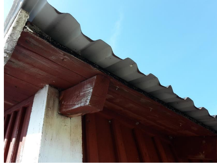
Bild 22: Tjärpapp under plåttaket.
