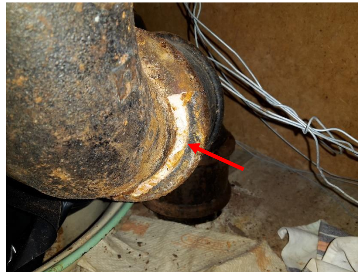
Bild 4: Avloppskitt under diskbänk.
