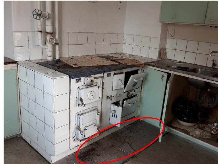
Bild 2: Klinkerfix framför vedspis i samtliga kök innehåller asbest.
