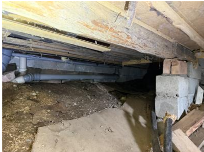
Vy över del av krypgrunden.
