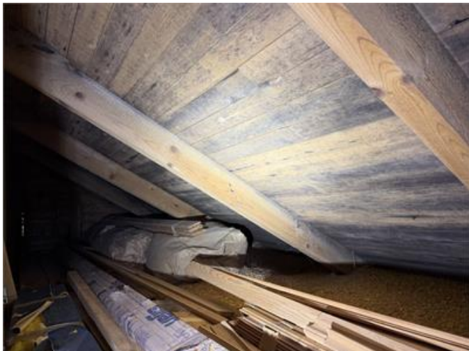
Vy över del av vindsutrymme.
