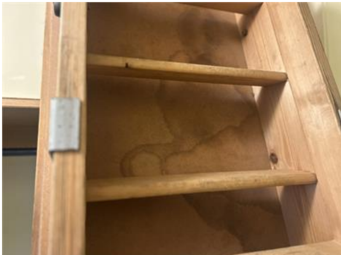
Vindslucka: Fuktanvisningar förekommer. Torra vid besiktning.
