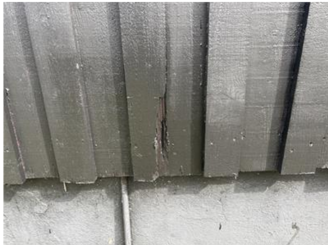
Rötskador fasad.
