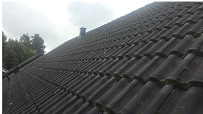
Översiktsbild, del av yttertak.
