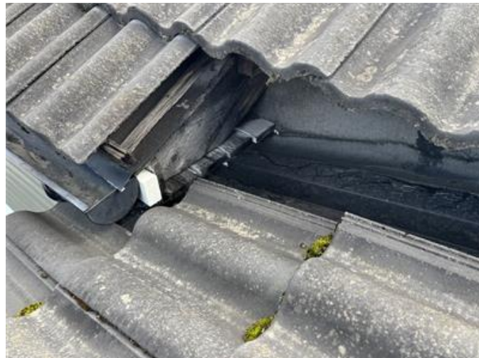
Bild visar väderutsatt takfot.
