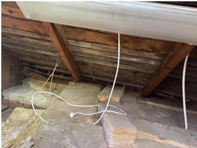
Översiktsbild av vinden från takluckan.
