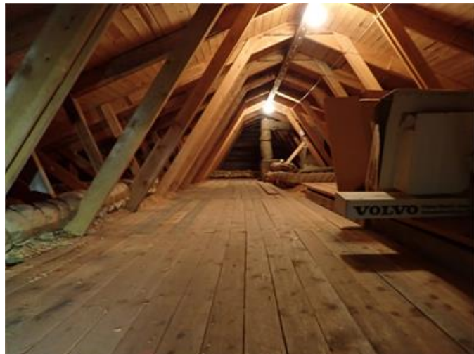
Vy över delar av husets vind.
