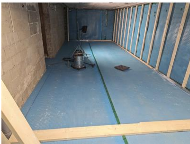
Källare: Säljares bild från renovering, platonmatta på vägg/golv.
