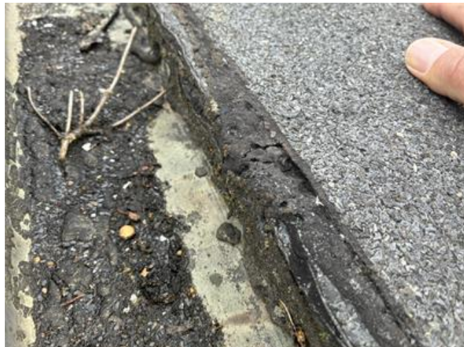
Bilden visar inbyggnadsränna med flera lager papp svetsad på dess fotplåt.
