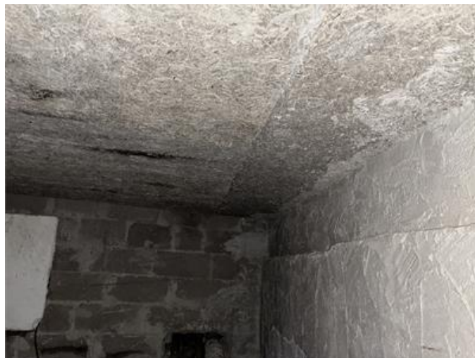
Bilden visar träullitskiva monterad på undersida hallens betongvalv från krypgrunden.
