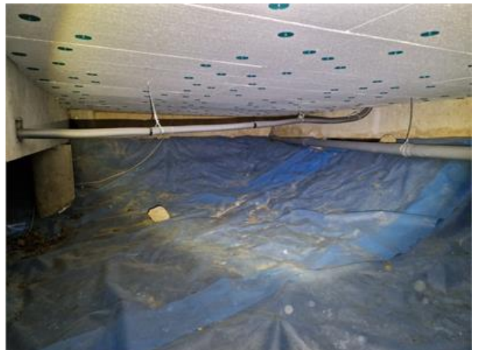
Krypgrund: Bjälklagets undersida är täckt med cellplastisolering.
