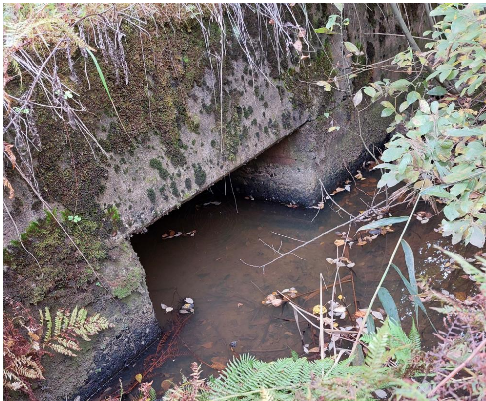
Kulverten under järnvägen som avvattnar det centrala redan exploaterade området.
