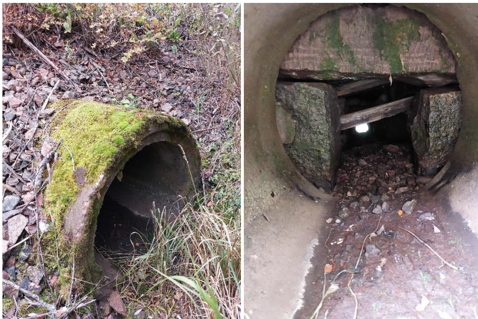
Bilder på kulverten i östra området. T.v. trumma med diameter på 70 cm. T.h. äldre stenkonstruktion längre in under järnvägen.
