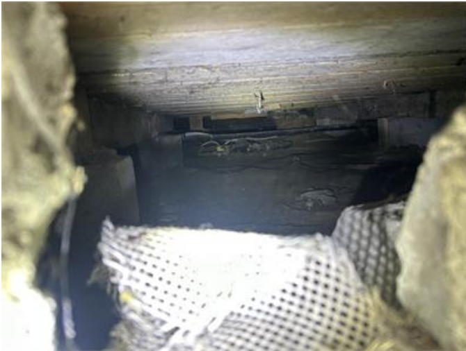
Torpargrund: Översiktsbild via ventil på södersida.
