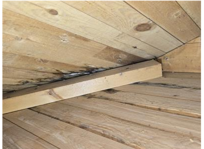
Nockvind: Fuktanvisningar vid rännal.
