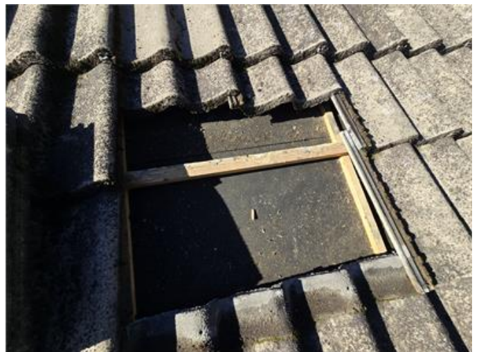
Tak: Stickprovskontroll under pannor.
