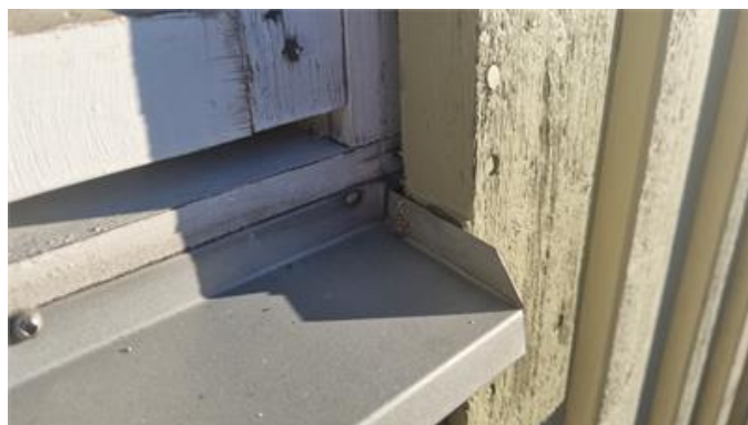
Exempelbild, otätheter kring fönsterbleck och målnings/underhållsbehov fönster.
