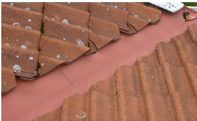
Spräckta och lösa pannor kring rännadal
