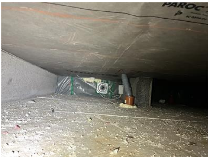
Bilden visar delar av krypgrunden.
