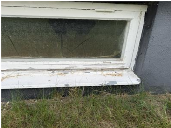
Äldre källarfönster på huset
