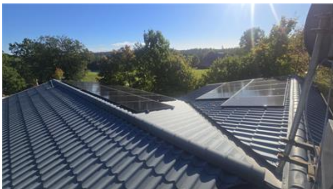
Översiktsbild, del av tak.
