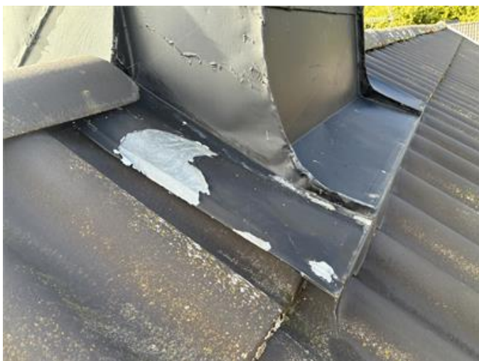
Tak: Frägsläpp på plåtinklädnad skorsten.
