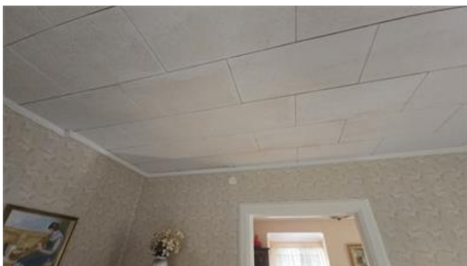
Exempelbild, missfärgningar i innertak, övre plan.
