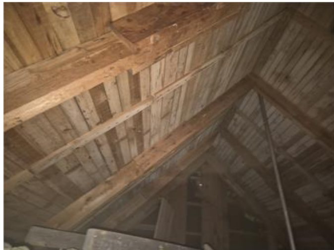
Bild frånnockvinden med missfärgning på svallbrädor.
