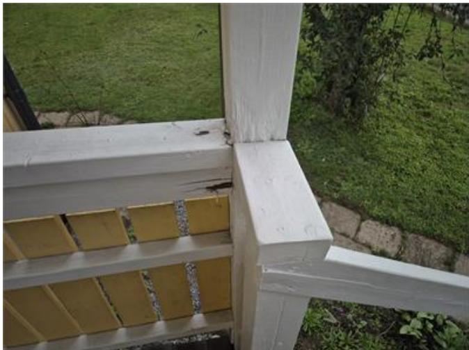
Rötskador förekommer i delar till entréverandor.
