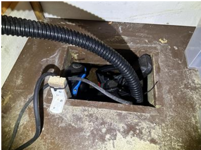
Dräneringshål i matkällare: Inspektionshål för vattennivå under betongplattan. enligt uppgift.
