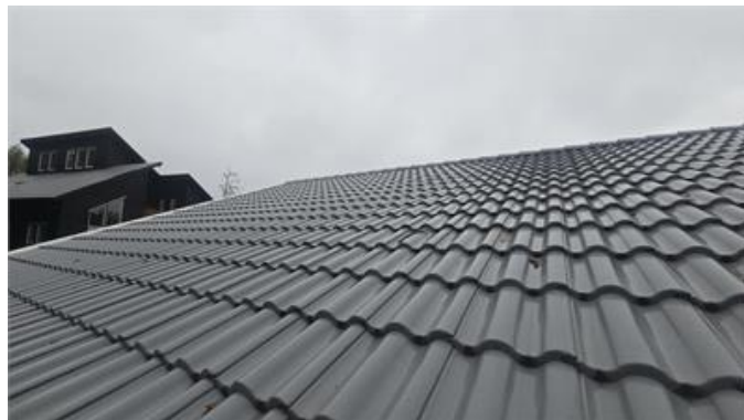
Översiktsbild, del av yttertak.
