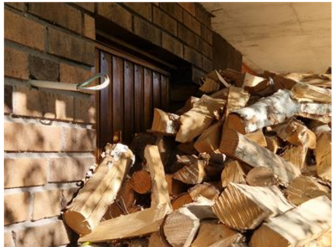
Fönster och Dörrar: Dörr till groventré var ej möjlig att besikta
