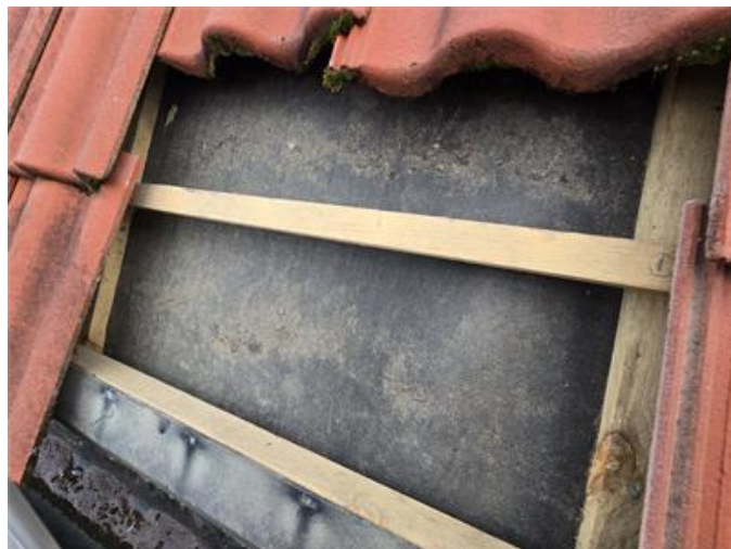
Tak: Stickprovskontroll under pannor.
