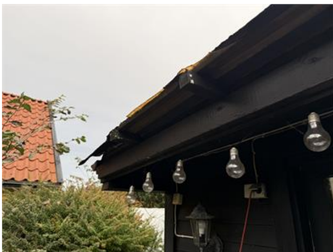
Vindskiva saknas på uterumstaket.
