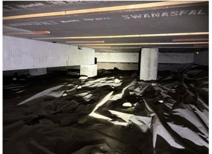
Översiktssbild av kryppgrund
