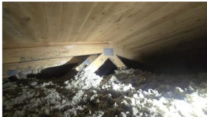
Översiktsbild, del av vind. Vy från luckan.
