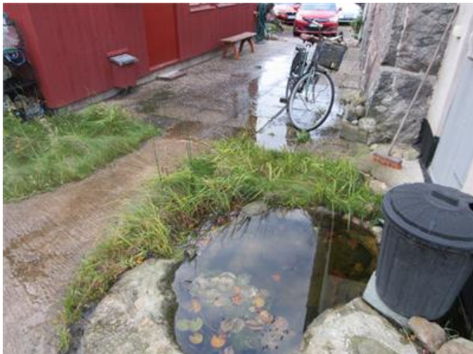
Vattenansamling på mark
