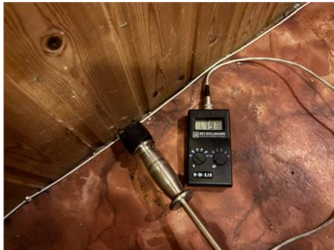
Fuktmätning nedre hall
