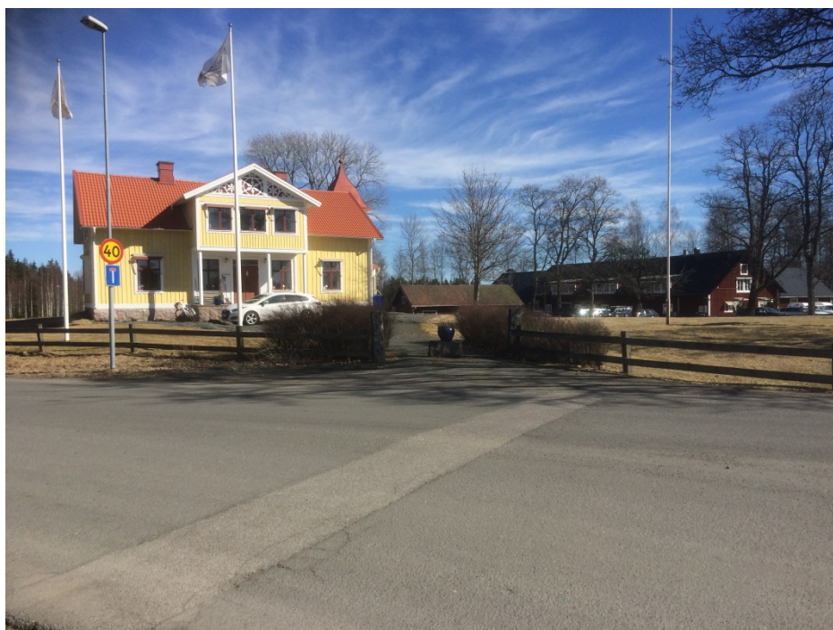
Mangårdsbyggnaden på Sörängens gård. Före detta ladugård till höger.
