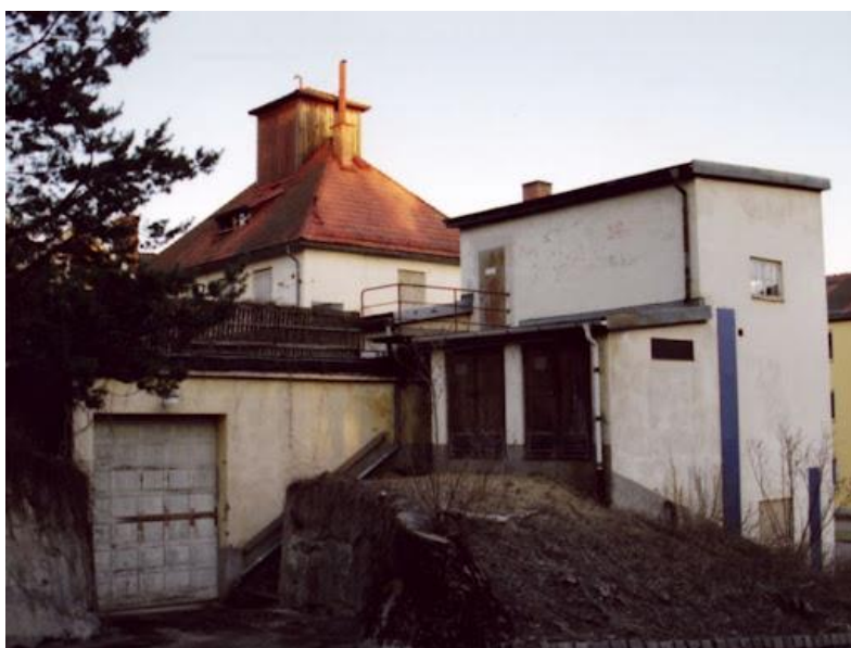
Pann-C med ställverk och transformatorhus
