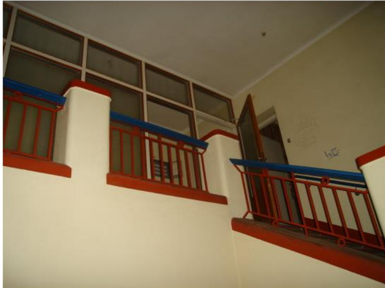
Det gamla fina trapphuset (som jag hoppas finns bevarat)
