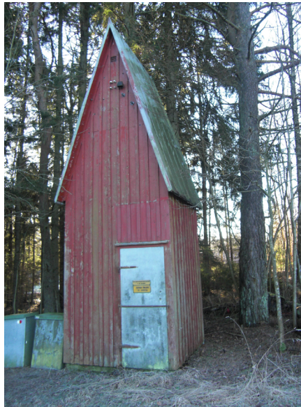
En bevarad transformatorstation som står inom planområdet längs Enebackevägen.
