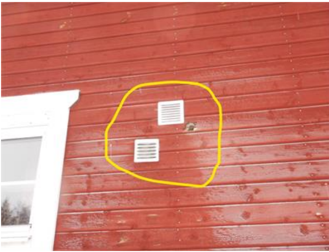
Utblås för köksfläkt genom fasad.
