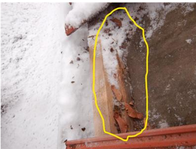
Tjärpapp avslutad mot takfotsbräde.
