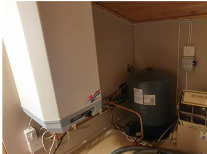
Sidovind 2: Fuktskydd saknas under varmvattenberedare och Hydropress.
